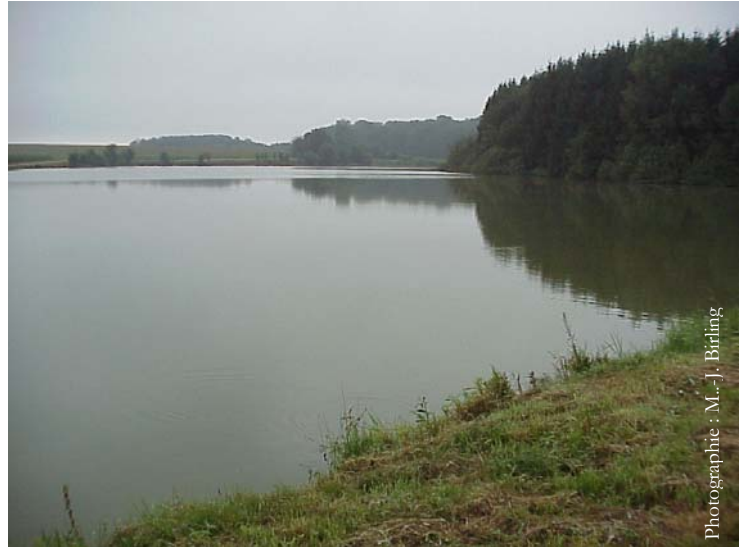
Vue sur l'un des étangs avant les travaux de restauration
