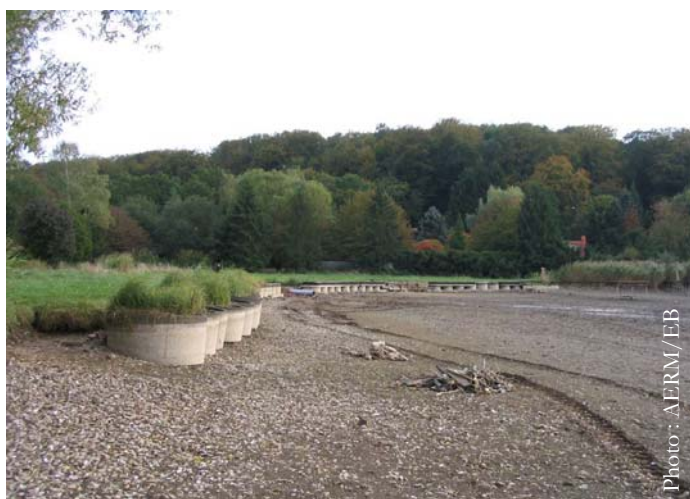
Berges de l'étang du Marais avant travaux : protection contre le batillage par un tunage en béton
