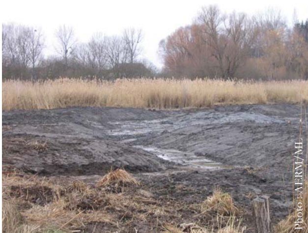
Diversification de la morphologie d'une cornée de l'étang du Welschhof : création d'îlots et de hauts-fonds (vue à la fin des travaux)
