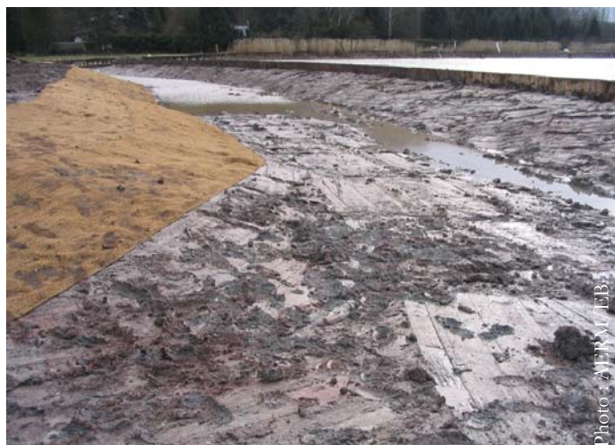
Berges de l'étang du Marais après travaux : retalutage en pente douce, protection contre le batillage par un tunage en bois
