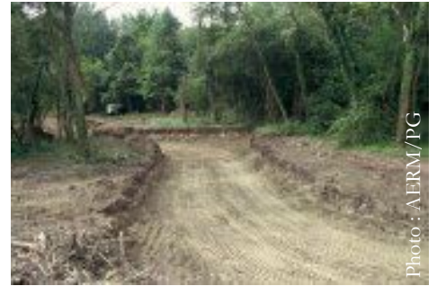
Chenal creusé, avant mise en eau
