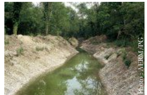
Eiswasser : tracé brut des chenaux après travaux
