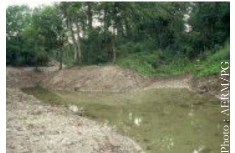
Chenal creusé, avant mise en eau
