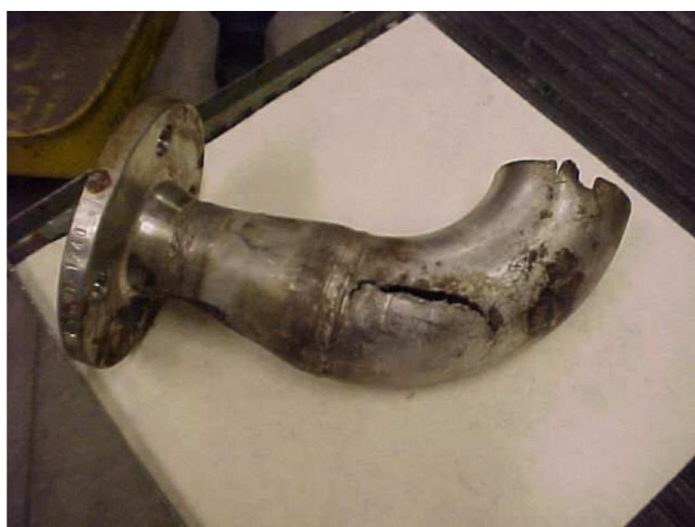
Rupture de conduite survenue suite à une corrosion – Source :Ministère chargé de l'environnement - DPPR / SEI / BARPI – IMPEL - http://www.aria.developpement-durable.gouv.fr/
