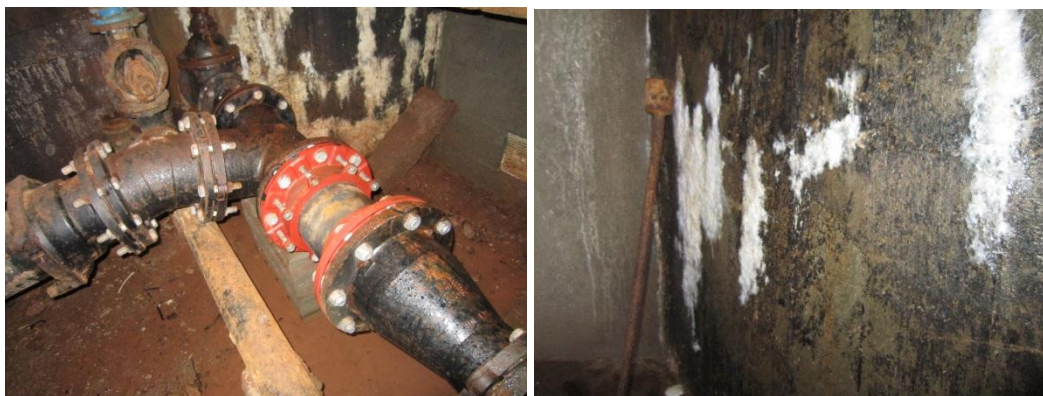
Fig. 87. Traces de moisissures, réservoir Closé
