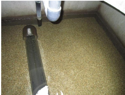
Fig. 3. Traitement par neutralite au réservoir de Sauceray
