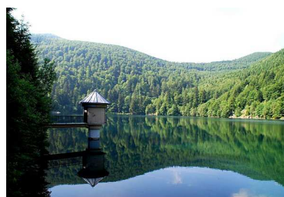
Barrage du Ballon :
