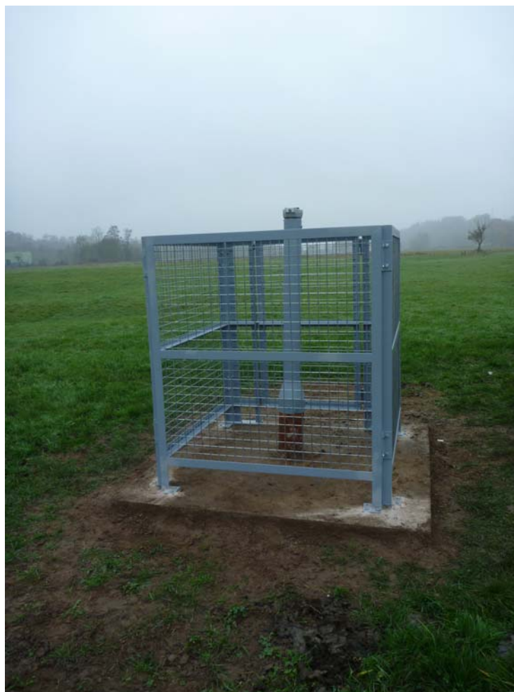
Illustration 16 - Photographie de la station de Chatel-sur-Moselle après travaux
