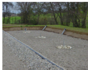
Alimentation souterraine par buses en surface
