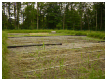
Alimentation de surface par drains percés au sol
