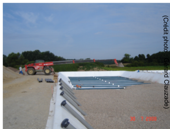
Exemple de mise en place des granulats avec engin "Maniscopic"
