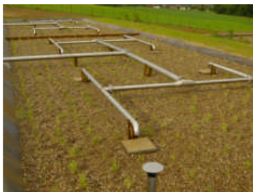
Alimentation aérienne par conduite en H
