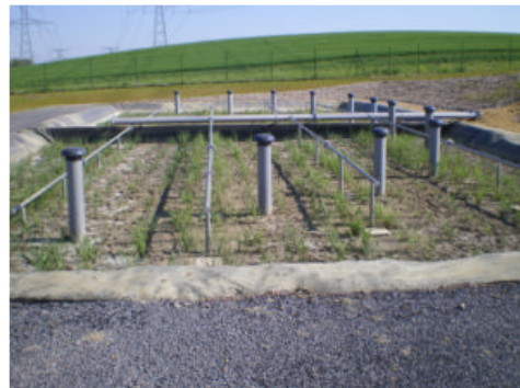
STEP de Valmestroff plusieurs mois après la mise en eau
