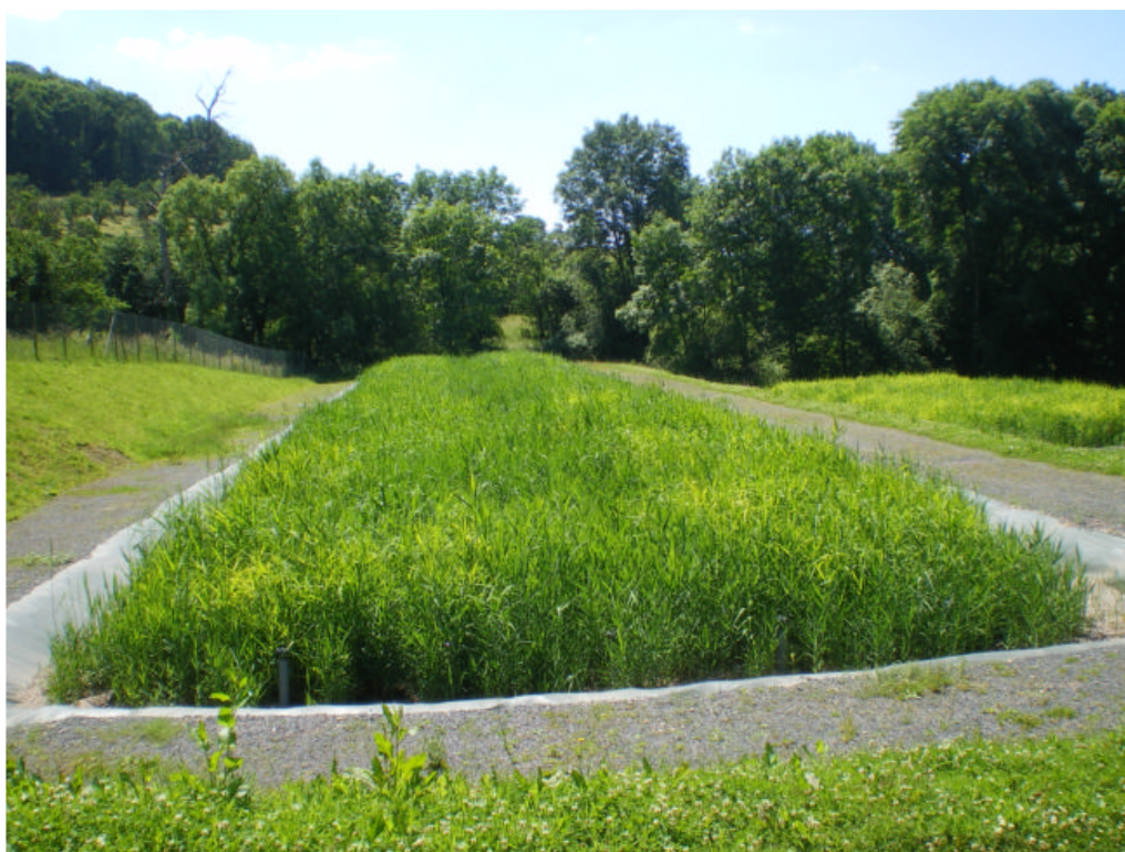
STEP de Saxon Sion environ un an après la mise en eau
