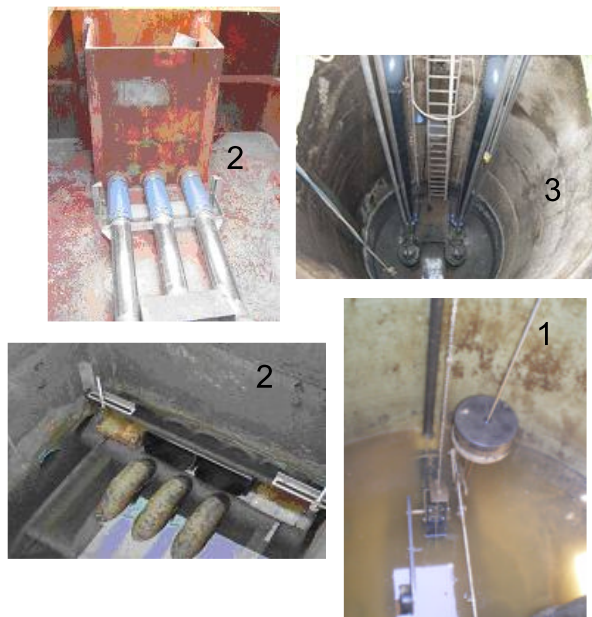
1 Chasse à clapet ; 2 Siphon ; 3 Pompage
