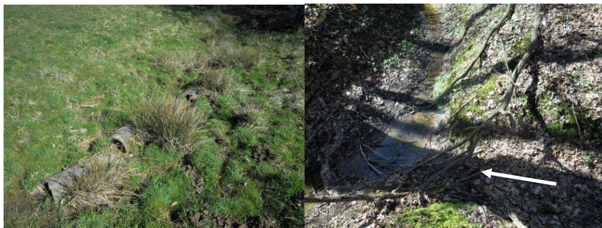
Série de buses dans la prairie et arrivée d'un petit fossé en rive gauche dans la partie boisée (point D sur la figure 19) (Dubost Environnement)
