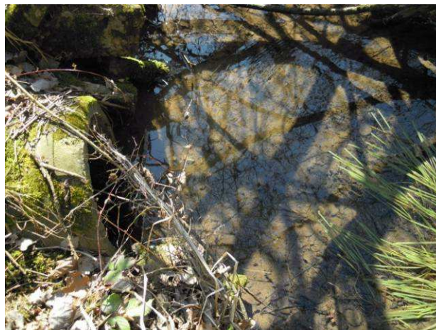
Passage busé près du chemin (point A sur la Figure 16) (Dubost Environnement)
