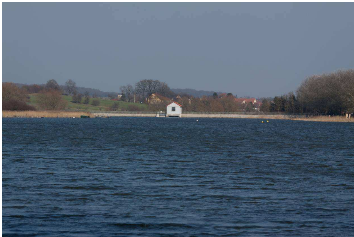
Vue sur la digue, où a été créée en amont la retenue
