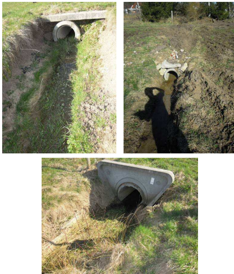
Différents passages busés correspondant à des chemins agricoles (Dubost Environnement)
