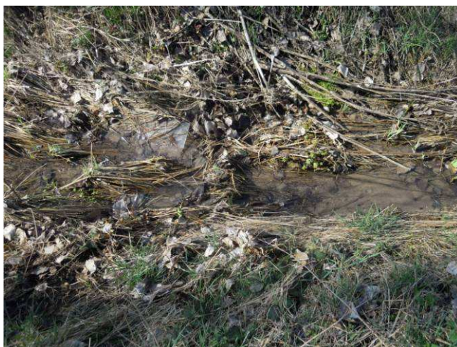
Fond du lit limoneux et colmaté par de la litière et divers débris végétaux (Dubost Environnement)
