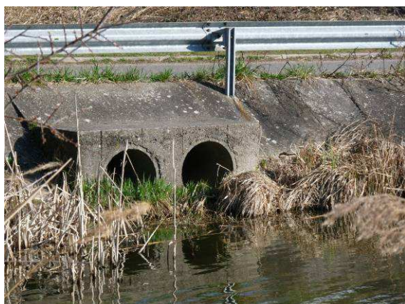
Passage busé à l'endroit où se jette le ruisseau de Hinter Krummfeld (Dubost Environnement)
