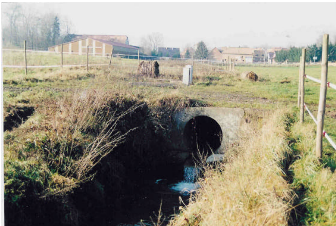
Sortie du tronçon busé de 700 m de longueur du Kolbsenbach dans la traversée de Reitwiller.
