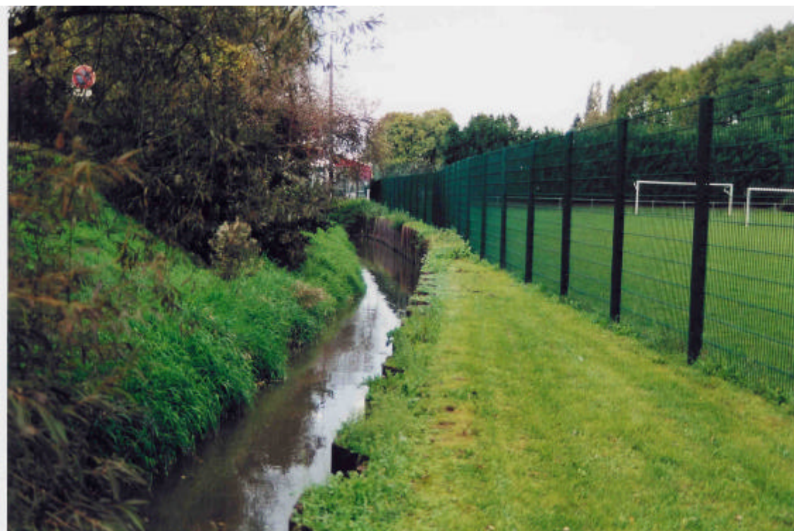
Lit majeur remblayé et berge rive droite de la Souffel constituée de palplanches métalliques au droit des terrains de sport situés à la périphérie Nord de Mundolsheim
