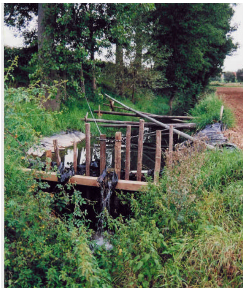
Ponceau complètement bouché et faisant obstacle à l'écoulement sur le Kolbsenbach entre Reitwiller et Pfettisheim.
