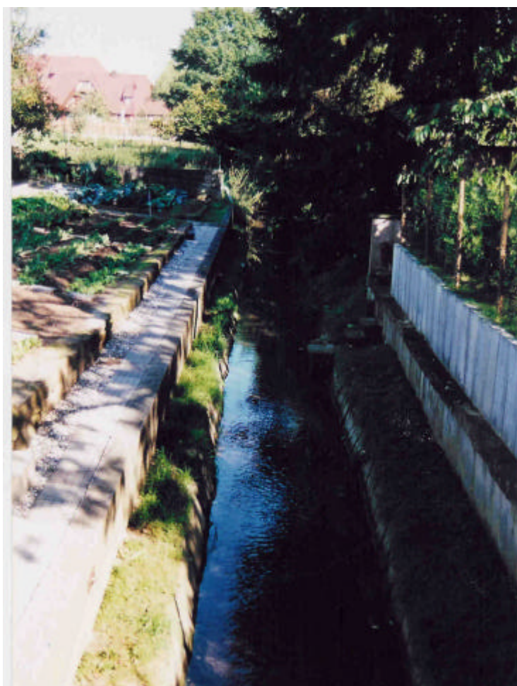
Lit majeur remblayé et berge rive droite de la Souffel constituée de palplanches métalliques au droit des terrains de sport situés à la périphérie Nord de Mundolsheim
