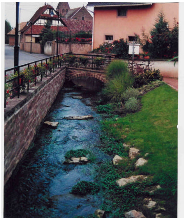
Sortie du tronçon busé de 700 m de longueur du Kolbsenbach dans la traversée de Reitwiller.
