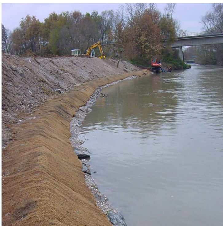
Travaux de stabilisation de berges sur la Moder à Kaltenhouse (photo Sater)
