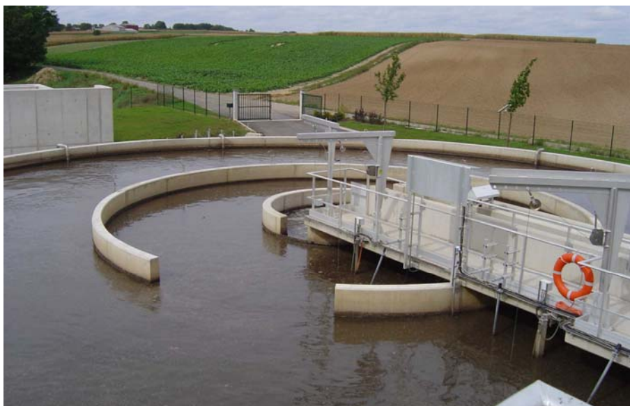
Station d'épuration de Griesheim-sur-Souffel (photo SATESA - 2004)
