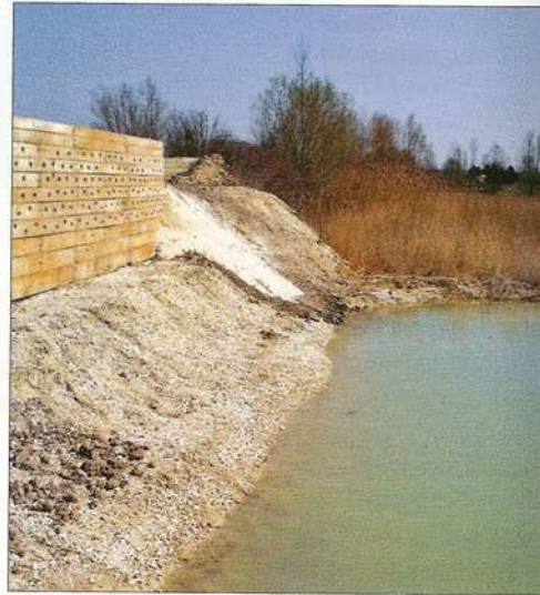
3. La mare assure une zone d'envol dégagée devant la paroi, Petit-Mesnil, Aube, mars 2009 (Vincent Ternois).
