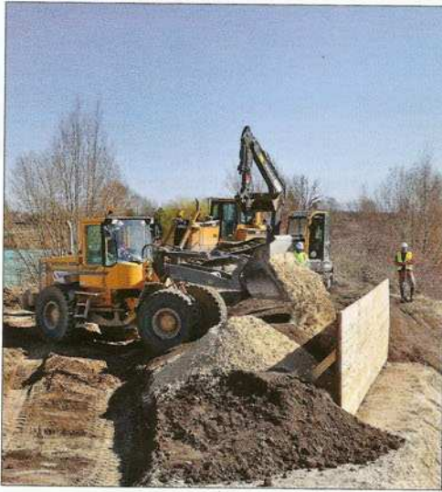
2. Mise en place du sable fin derrière la paroi en bois, Petit-Mesnil, Aube, mars 2009 (Stéphane Bellenoue).
