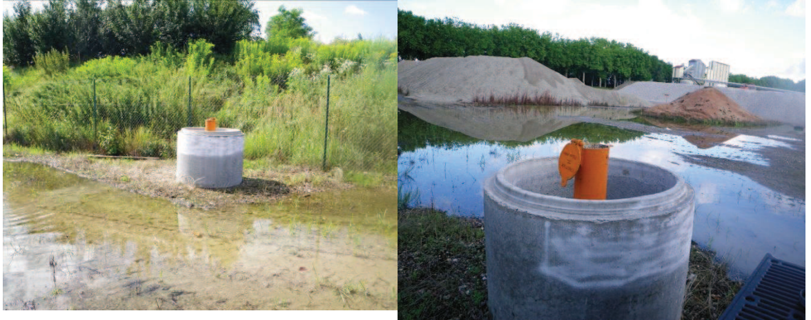
Illustration 17 : photographie de l'environnement immédiat du piézomètre 02726X0339/GRAV
