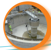
Station à boue activée
