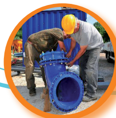
Chantier de la nouvelle Station d'épuration d'Olwisheim (68)
