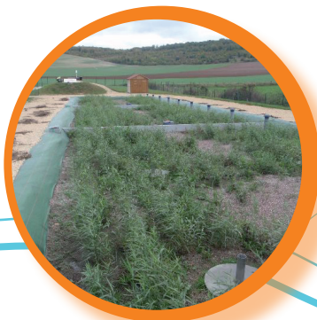
Station à filtre planté de roseaux
