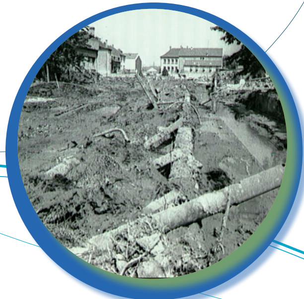
Dégâts suite à la rupture des digues du bassin de décantation des suies de la centrale thermique d'Emile Huchet à Carling en 1978.
