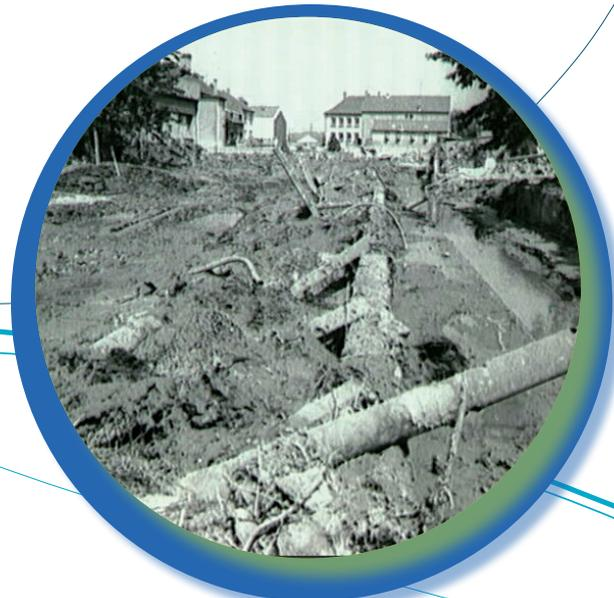
Dégâts suite à la rupture des digues du bassin de décantation des suies de la centrale thermique d'Emile Huchet à Carling en 1978.
