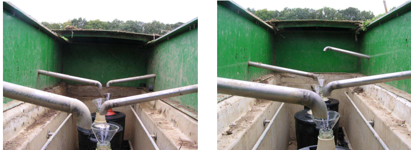
Photographie 13. Dégâts sur les dispositifs enterrés de collecte des eaux gravitaires (automne 2004) collecteurs et plaque lysimétriques en place (gauche) ; collecteur arrière et plaque lysimétrique déplacés (droite)
