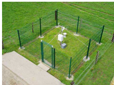
Photographie 9. Station météorologique du site de la Bouzule
