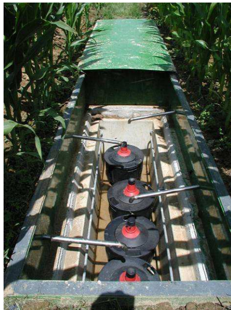
Photographie 12. Dispositif enterré de collecte des eaux gravitaires
