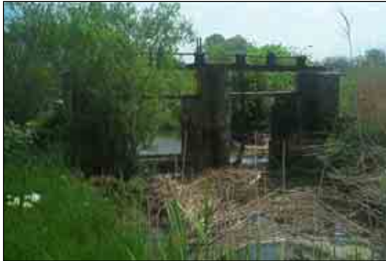
la Rode au tronçon 5 : barrage délabré Photo Ecodève-2004
