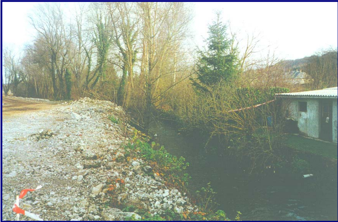
Tronçon ALZ1d : la rive gauche est remblayée, avec remaniement de matériaux en sommet de berge, au détriment de la ripisylve. Photo Atelier des Territoires.
