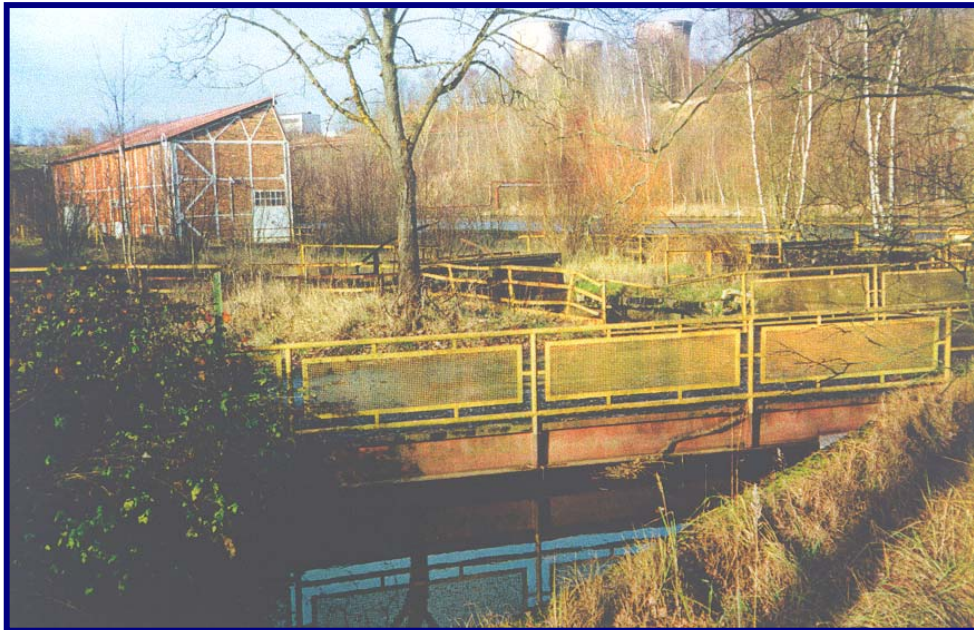
Tronçon ALZ2 : le cours d'eau est aménagé pour permettre d'alimenter d'anciens bassins de décantation en zone industrielle. Photo Atelier des Territoires.
