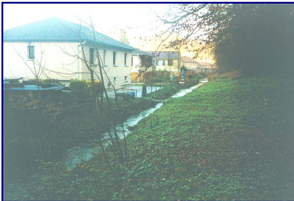
Tronçon ALZ1a : urbanisation linéaire en rive gauche, tandis que la rive droite est restée plus naturelle, sur ce tronçon encadré de versants boisés. Photo Atelier des Territoires.
