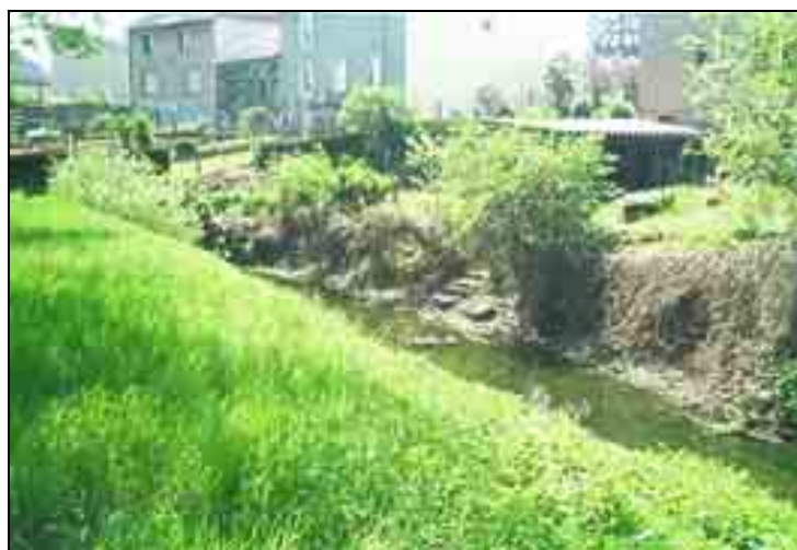
passage du Mutterbach à Rémering Photo ECODEVE
