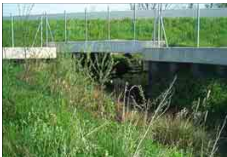
traversée du Mutterbach par l'autoroute Photo ECODEVE
