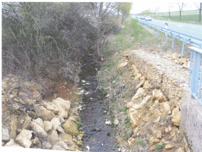
photo 19 : Le Chevillon à l'amont de la traversée de la D906 : protection de berges par enrochement et gabions (avril 2003)
