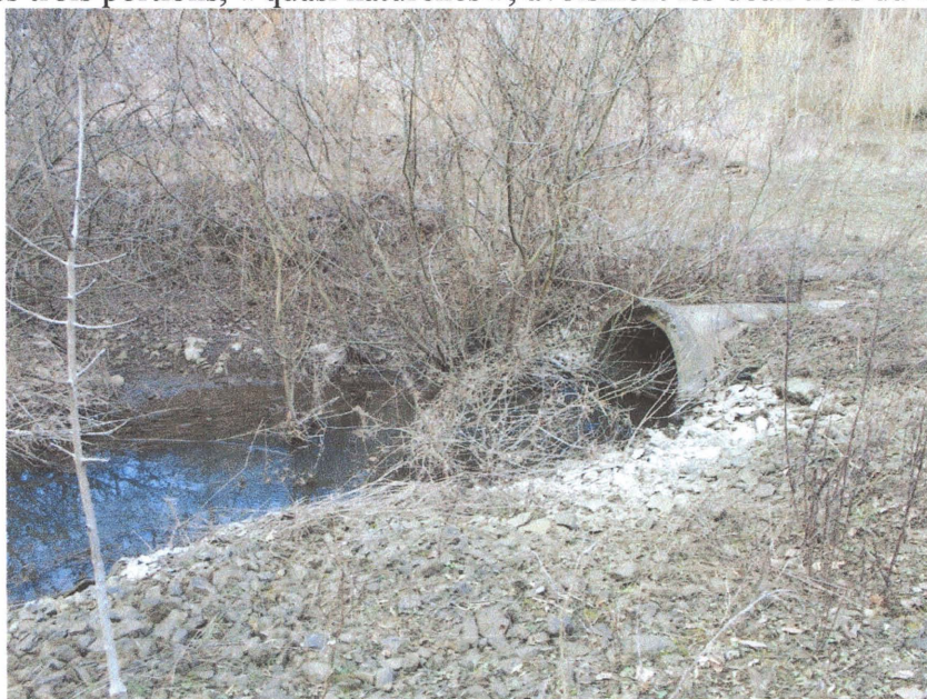
photo 12 : entrée du busage (limite tronçons 3a et 3b) mars 2003
