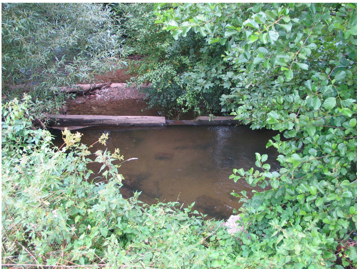
Photo n°17 : Ancien ouvrage entre Colroy-la-Grande et Provenchères-sur-Fave (vue vers l'aval)
