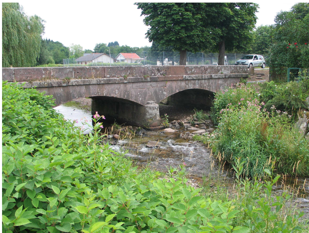
Photo n° 2: pont à l'aval du hameau « Les Ailes » à Provenchères-sur-Fave (tronçon 8)
