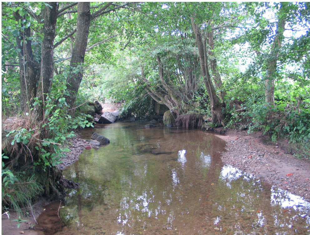
Photo n°18 : Ancien ouvrage en ruine, à l'amont de la confluence du Rau de Ste-Catherine
