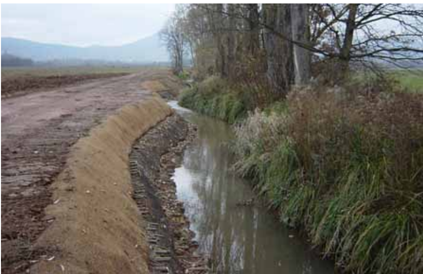
Travaux de stabilisation de berges sur la Scheer à Epfig (photo SATER)
