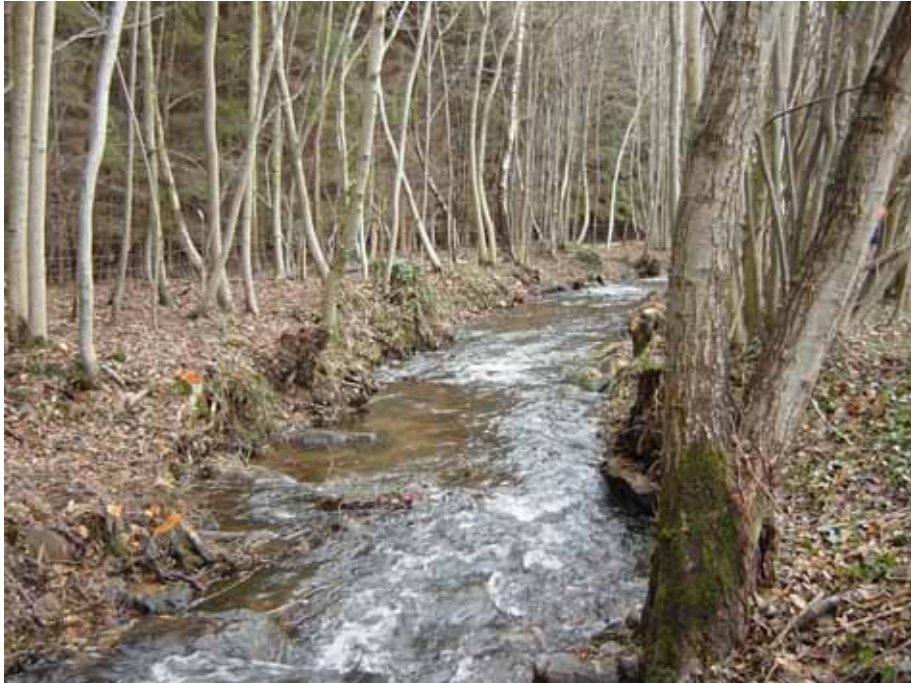
Travaux d'entretien de la ripisylve sur l'Ehn à Klingenthal (photo SATER)
