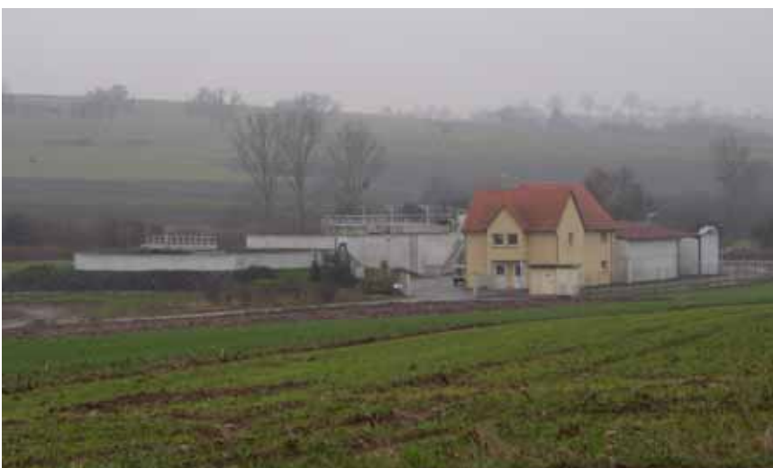
La station d'épuration de Péchelbronn (photo RID 67 - déc 04)
