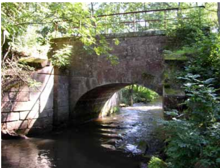
Pont SNCF du Hausauerbach (à la hauteur de Riedseltz) (photo RID 67 sept 04)
