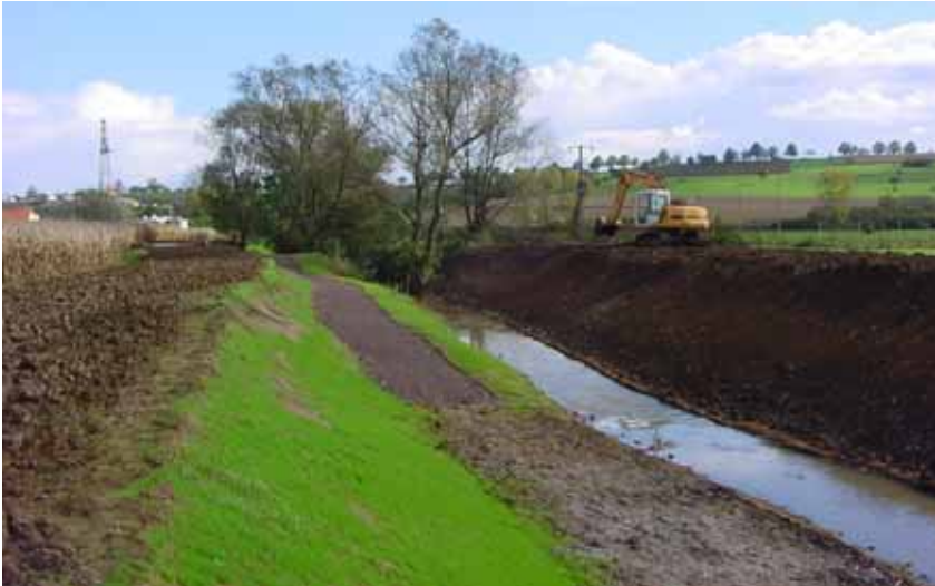
Travaux sur le Seltzbach en aval de Kutzenhausen (photo SATER)
