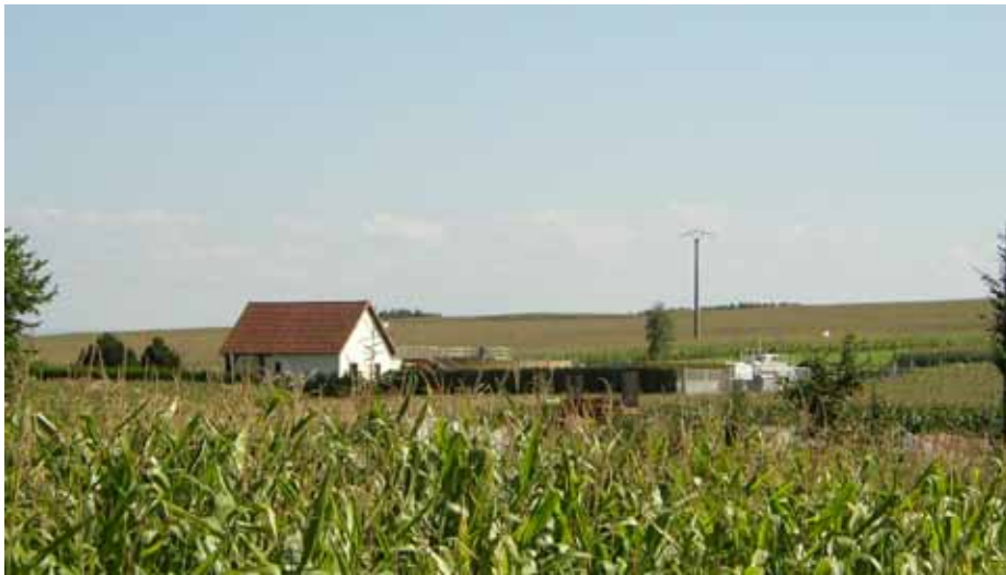
Station d'épuration de Hoffen (photo RID 67 sept 04)
