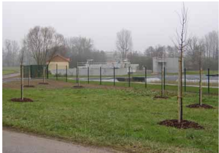
La station d'épuration d'Ingolsheim (photo RID 67 - déc 04)
