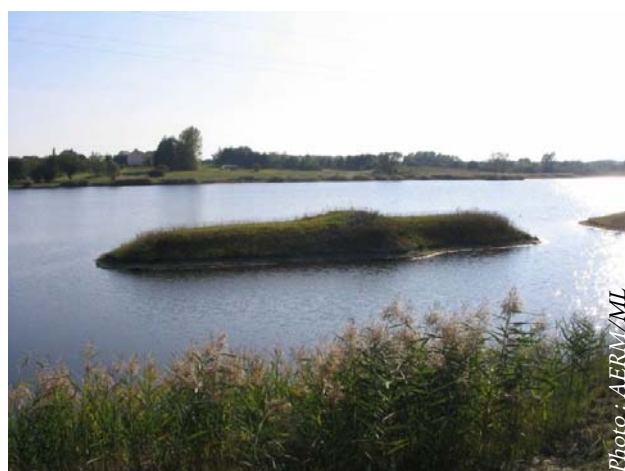
Hauts fonds sur l'étang de Hoste-haut (9 mois après travaux, étang en cours de remplissage)
