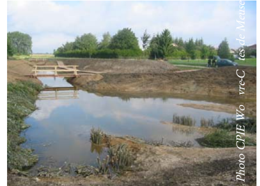
Zone humide de Fresnes après travaux
