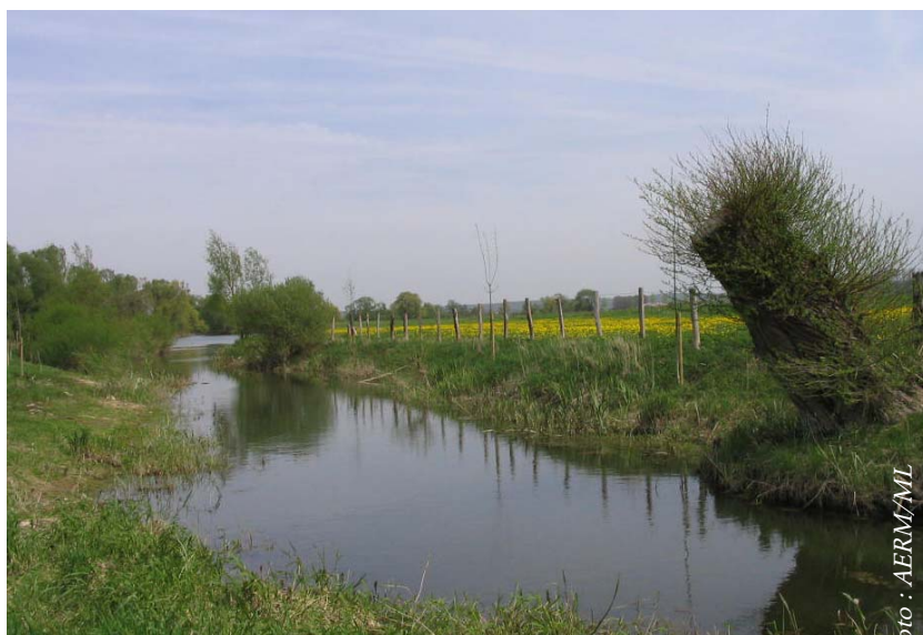
Noue après travaux : berge retalutée (à gauche), plantations et saule recépage (à droite)
