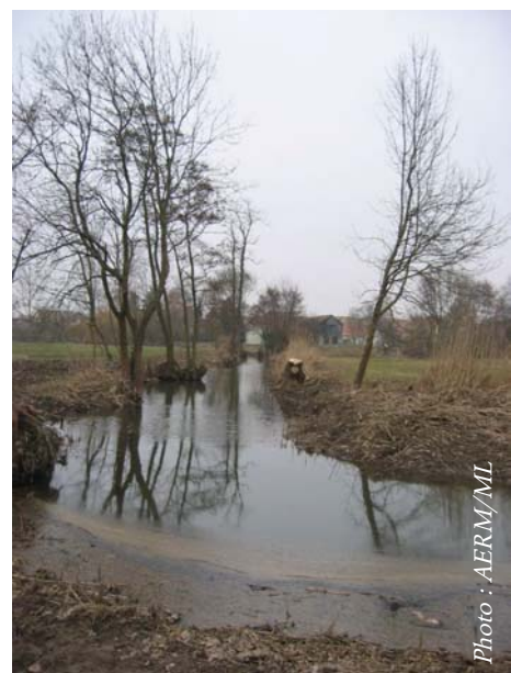
Chenal après travaux
