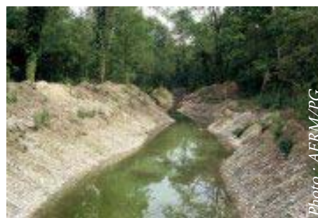
Eiswasser : tracé brut des chenaux après travaux
