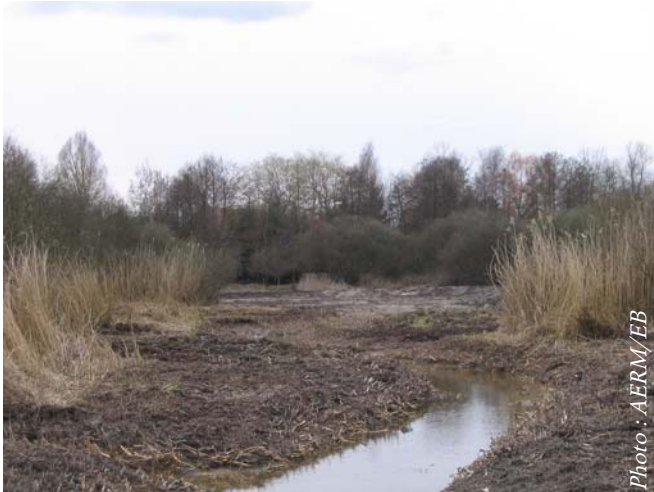
Chenaux dans la roselière de Hoste-Bas (juste après travaux)
