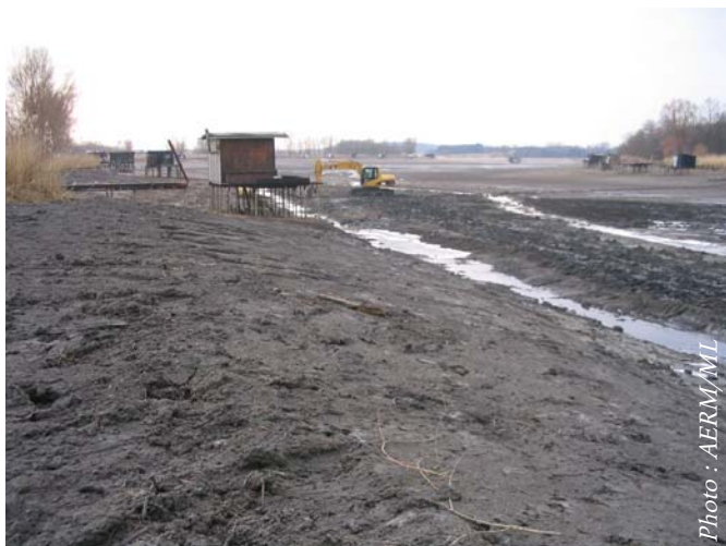
Engraissement des berges sur l'étang du Welschhof (vue à la fin des travaux)
