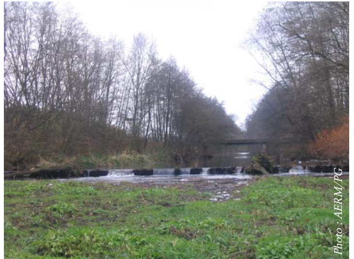
La Fecht en amont de Bennwihr : aménagements hydrauliques (seuil), modifiant le fonctionnement de la rivière
