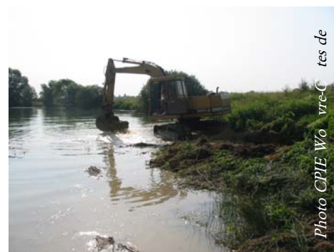
Talutage des berges de l'étang en pentes douces
