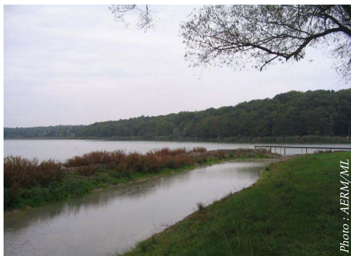
Berges de l'Étang des Marais (1 an après travaux)
