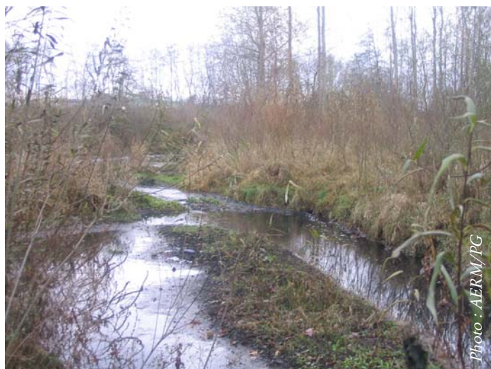
Chenal recréé : tracé sinueux et écoulement diversifiés (alternance courants lents / courants rapides), atterrissements, ...
