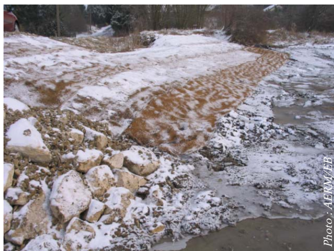
Engraissement de la berge de l'étang de Hirbach pour favoriser le développement de la roselière et limiter l'érosion
