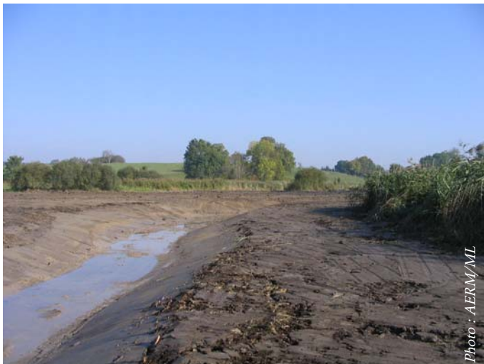
Chenal de diversification de la roselière (non rectiligne et en pente douce) et zone décapée
