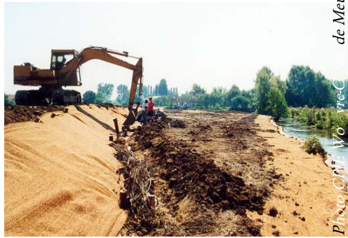
Déplacement et retalutage de la digue (pentes douces)
