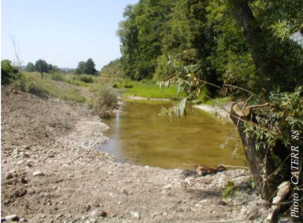
Chenal à la fin des travaux (2003)
