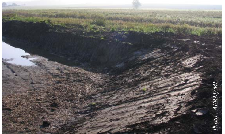
Diversification des berges des clairières : alternance de pentes douces et de pentes raides
