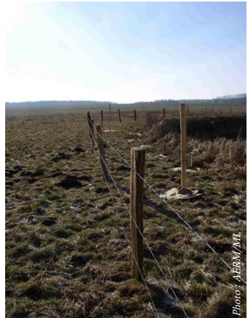
Clôtures installées pour la mise en défens des berges d'un ruisseau amont.
