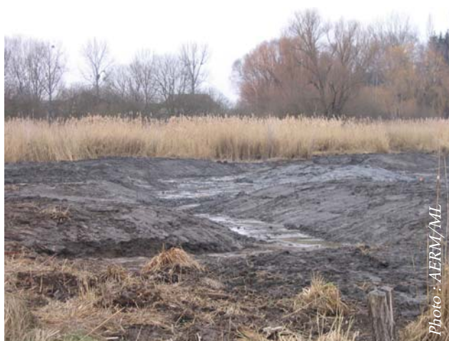
Diversification de la morphologie d'une cornée de l'étang du Welschhof : création d'îlots et de hauts-fonds (vue à la fin des travaux)
