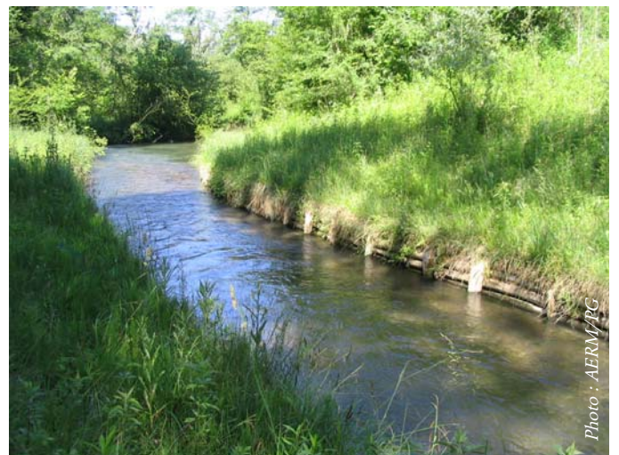
Breitsandgiessen (juin 2006) : secteur avec protection du pied de berge par tunage
