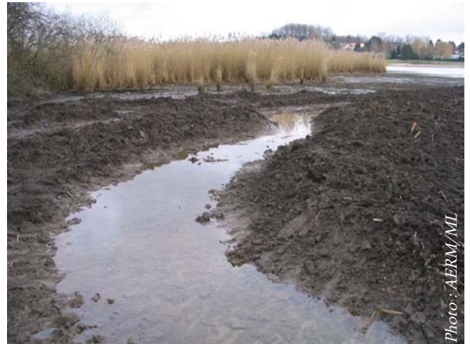
Chenaux dans les roselières de l'étang du Marais (hiver 2005, juste après travaux)
