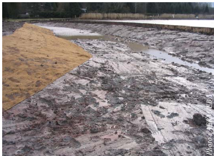
Berges de l'étang du Marais après travaux : retalutage en pente douce, protection contre le battillage par un tunage en bois
