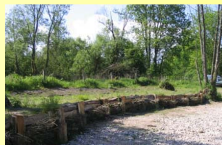
Après travaux : tunage en bois accompagné d'un lit de branches
