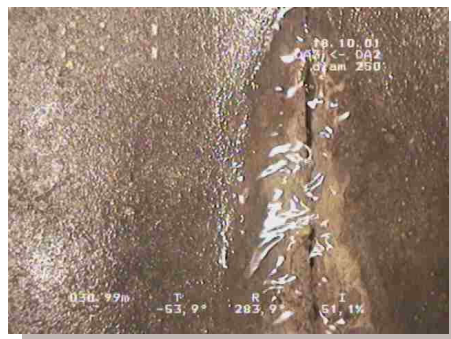
Figure 1 : Exemple d'infiltration apparente à un emboîtement de canalisations
