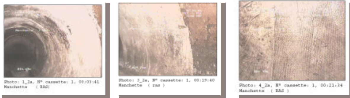
Figure 14 : Exemples de chemisage partiel observé lors de l'inspection visuelle d'un tronçon
