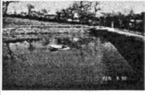
**Mauvais** : Placer ce type de station après un réseau unitaire et de surcroît après un déversoir d'orage mal calé
