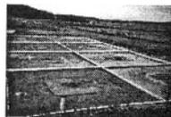
**Bonne idée :** Découper la surface en unités élémentaires pour mieux répartir l'effluent sur des plages d'infiltration de surface réduite
