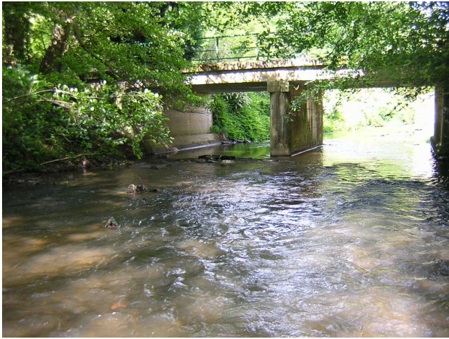
Annexe 5A1 : La station de prélèvement « Sauer ». Vue amont.
