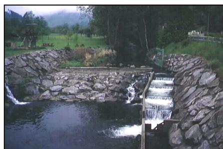
Passe à poissons sur un barrage en enrochement sur la Lauch.
