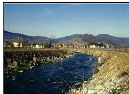
La Weiss lourdement recalibrée : largeur du lit régulière, écoulement et profondeur variés.
