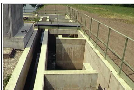
Passe à poisson à bacs successifs du barrage de Muttersholtz sur l'III.
