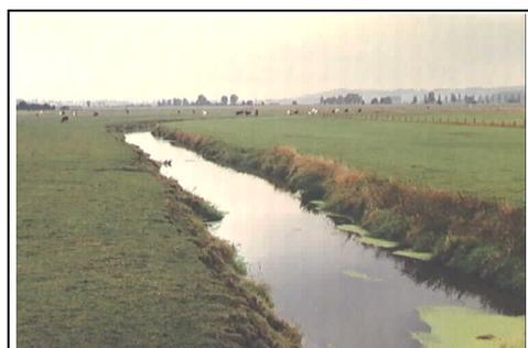
La Seille amont rectifiée et recalibrée : **situation dégradée, inondabilité modifiée.**
