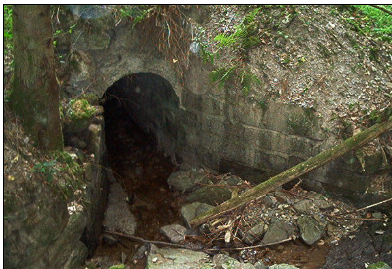
Le ruisseau du Giessen au tronçon 2 : Ouvrage infranchissable par les poissons. Photo Ecodève
