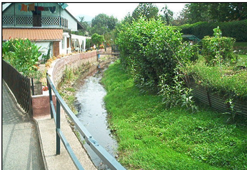
le ruisseau du Giessen à l'entrée de Maisongoutte cours d'eau bloqué photo Ecodève
