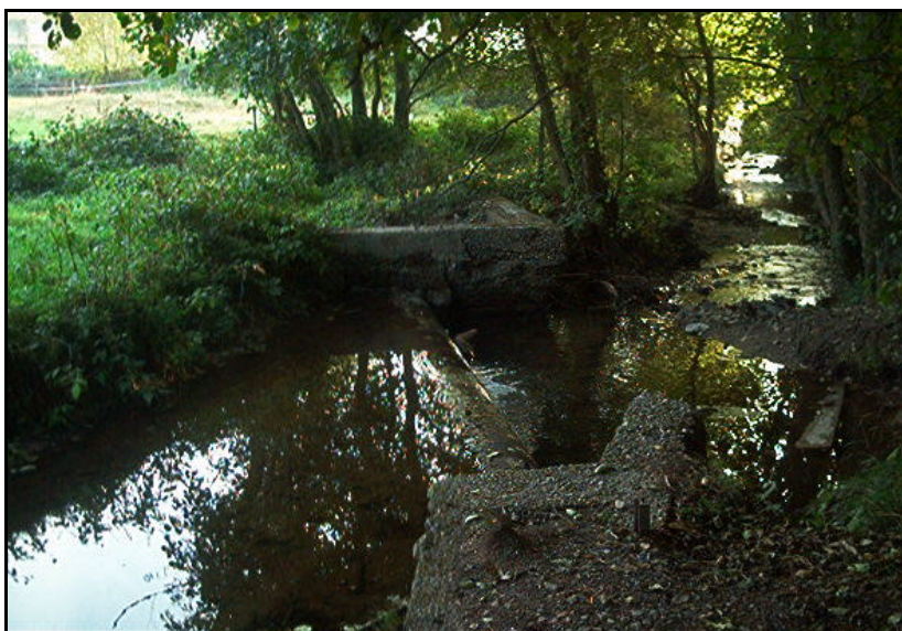
le ruisseau du Giessen à Steige petit seuil en béton photo Ecodève
