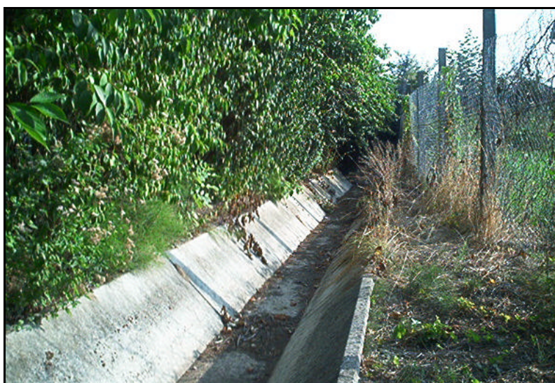
le Landweggraben sur le tronçon 1c à Hilsenheim : cours d'eau bétonné Photo Ecodève
