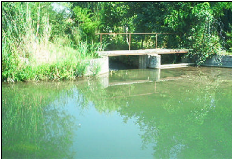
dérivation du bief du Muhlbach de Daubensand : ouvrage hydraulique Photo Ecodève
