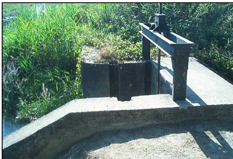
le Brunnwasser sur le tronçon 1a : prise d'eau sur le contre canal Photo Ecodève
