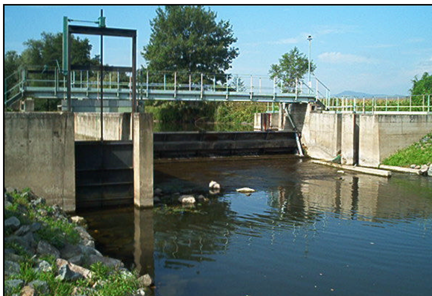
le Fischerschluth sur le tronçon 2 à Ebersmunster : ouvrage hydraulique de gestion de débit Photo Ecodève
