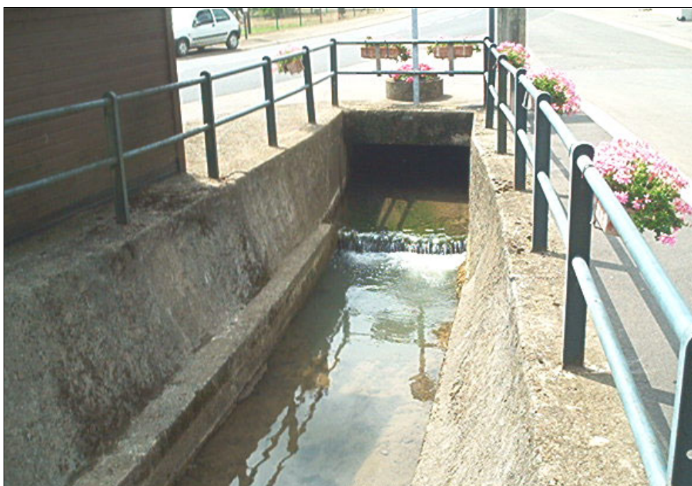
Le ruisseau de Volmerange à l'aval de Molvange : Sortie de la partie souterraine Photo Ecodève
