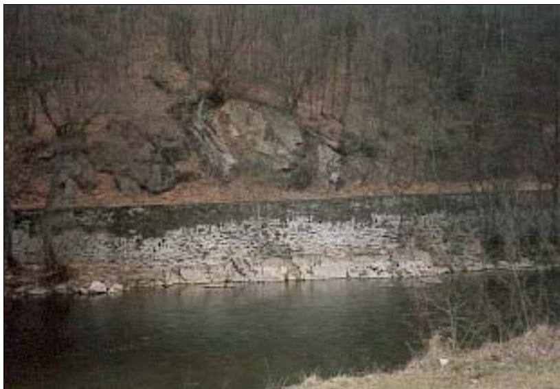
la Semoy sur le tronçon 3a: muret de soutènement Photo AERU - 1998
