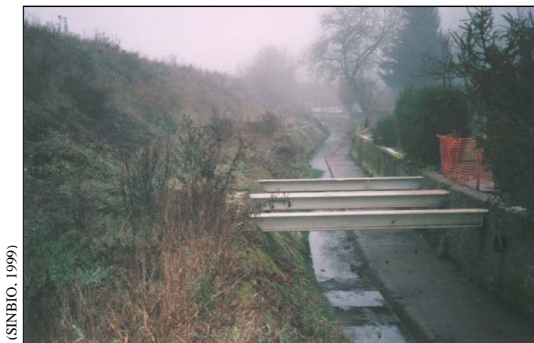
Tronçon 2b Secteur aval anthropisé
