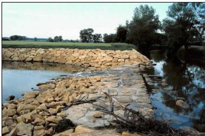
Seuil en enrochement à Holling, lissant les écoulements et banalisant le lit mineur sur plusieurs centaines de mètres en amont. Photo AERM.
