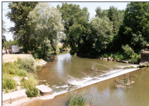
Barrage infranchissable pour la faune piscicole et formant une retenue importante à l'amont, favorisant l'envasement et banalisant les écoulements. Photo AERM.
