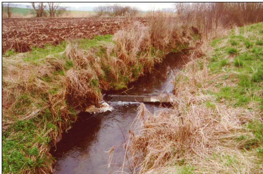
La Nied Française à l'aval de Frémery : seuil béton épisodiquement franchissable, datant de la 2 ème guerre mondiale.
