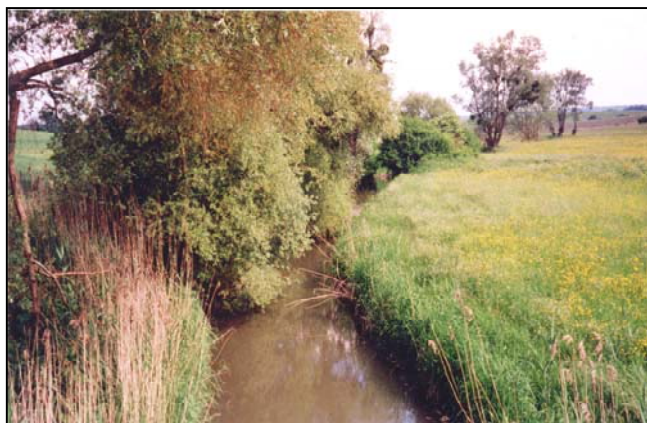
Vue sur la Seille depuis le pont de la RD 199g (Se 3c) : bon état général du lit et des berges. Photo ECOLOR
