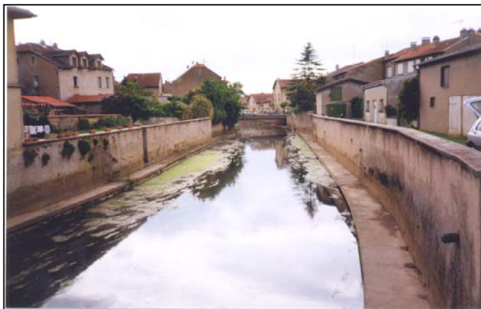
La Seille, complètement artificialisée, à Vic-sur-Seille (Se 9b), qualité physique très mauvaise. Photo ECOLOR
