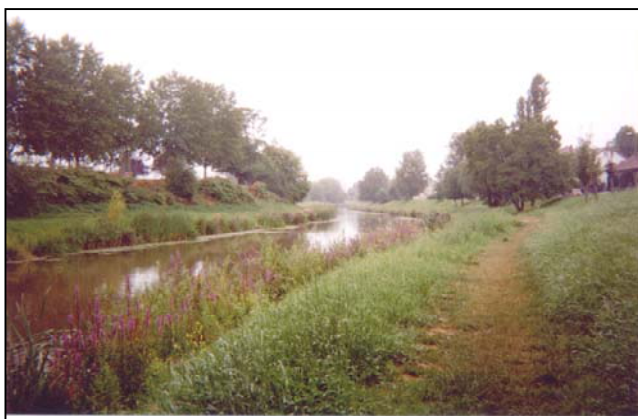
La Seille à Metz (Se 30h) : berges souvent naturelles mais sans ripisylve, lit mineur canalisé. Photo ECOLOR
