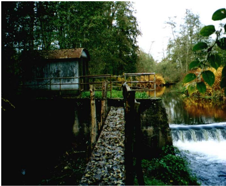
Barrage (tronçon 11b)
