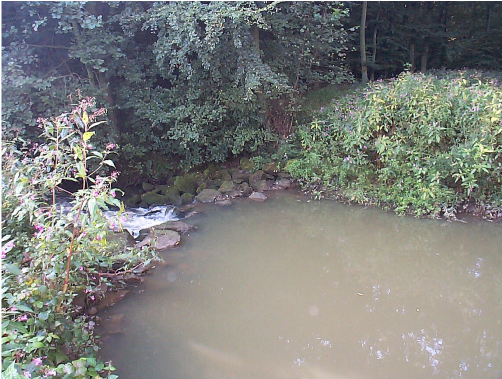
❶ Le nouveau Seltzbach à Hatten – Seuil – Tronçon 10aA – Photo F. SCHILLING, ONF
