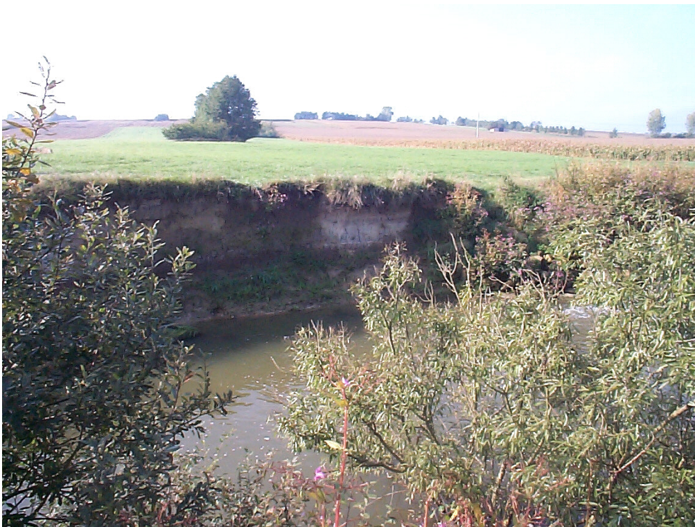
⑧ Le Nouveau Seltzbach à Hatten – Tronçon 9cA – Poche d'érosion - Photo F. SCHILLING, ONF
