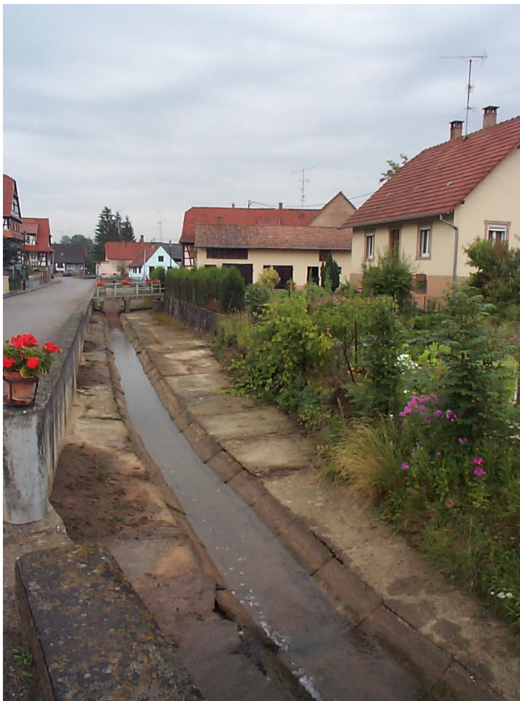
❷ Le Seltzbach à Preuschedorf – Tronçon 5a - Photo F. SCHILLING, ONF
