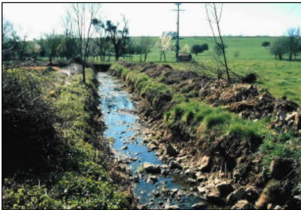
Le Woigot sur son cours amont, à Mairy-Mainville : lit rectifié et recalibré, milieu banalisé, végétation des berges absente, qualité physique médiocre
