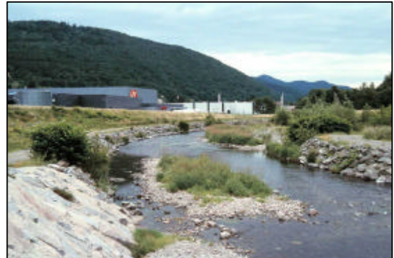
Traversée de Saint Amarin : lit mineur peu diversifié, berges bloquées par enrochement, lit majeur réduit par l'urbanisation. Photo AERM
