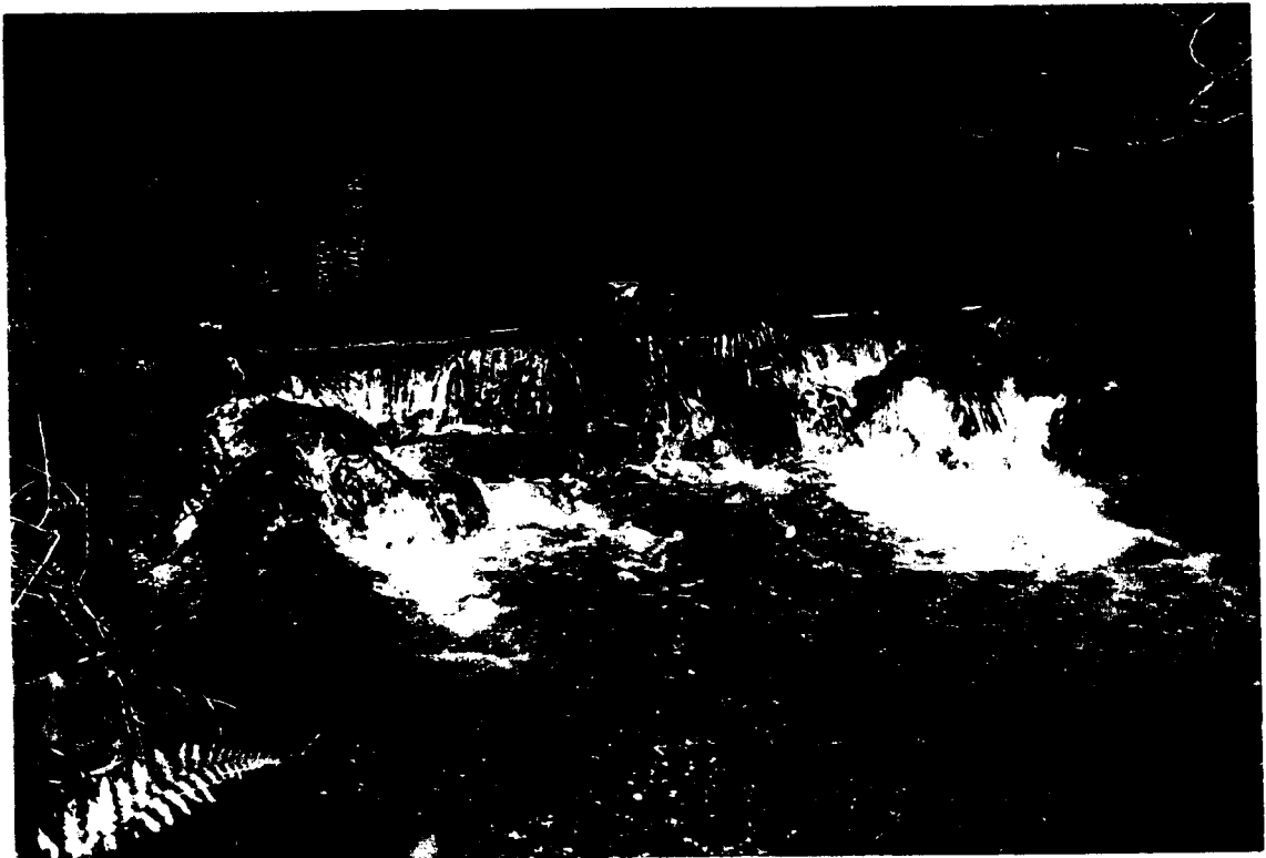
3 piquets (on peut en mettre plus); roches qui évitent le creusement de la fosse d'appel Crédit photo : ONF
