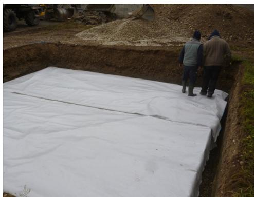
Pose d'un géotextile et remblai perméable
