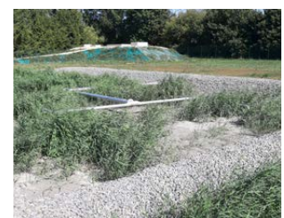
Dans le cadre du plan triennal d'assainissement, la commune de Sormonne (08) a bénéficié d'une aide pour la construction d'une station d'épuration de type filtres plantés de roseaux de 650 équivalents-habitants.
