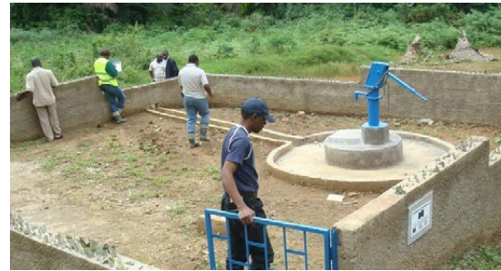
Un ouvrage d’alimentation en eau potable réalisé dans le cadre du projet d’incubation sur le bassin de la Sagana (Cameroun)
