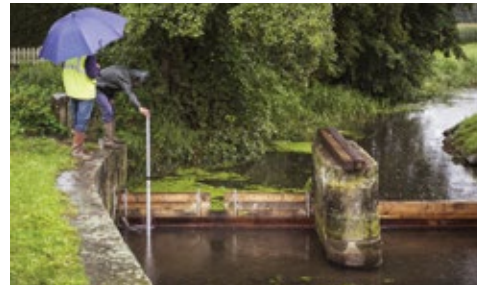
Barrage à poutrelles sur l'Andlau (67), à supprimer pour rétablir la continuité écologique. Étude préalable.
