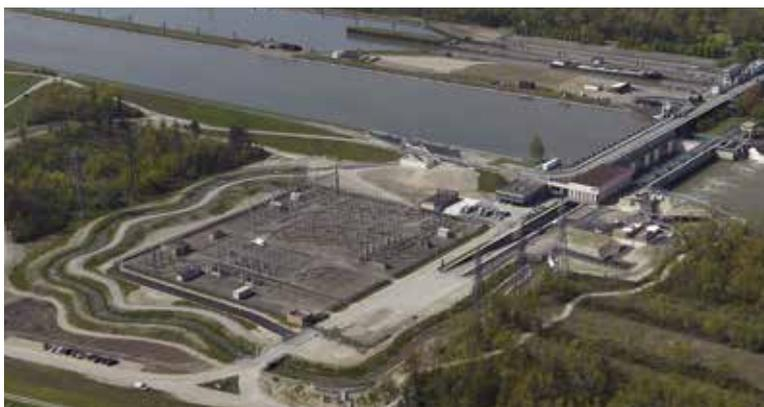
La nouvelle passe à poissons (au premier plan) va permettre aux poissons migrateurs de franchir les 13 m de dénivelé qui séparent l'amont de l'aval du barrage hydroélectrique de Strasbourg.
