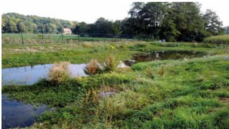
Les zones de rejet végétalisées en sortie de station d'épuration se développent sur le bassin Rhin-Meuse.
