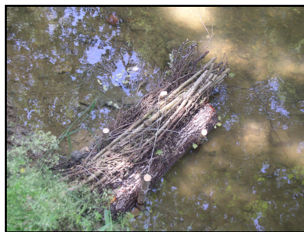
Pose de ligatures et coupe de piquets
