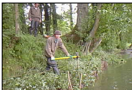
Installation de la végétation et enfoncement des boutures
