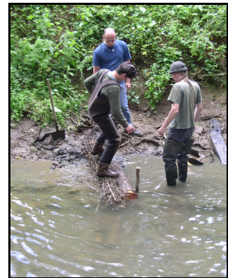
Pose du tronc, des fagots et des piquets
