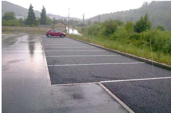
*Structure réservoir et enrobés drainants (à droite) durant un évènement pluvieux*
