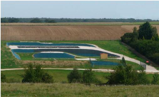
*Station de traitement des eaux usées fonctionnant gravitairement en utilisant la dénivellée du terrain naturel*
