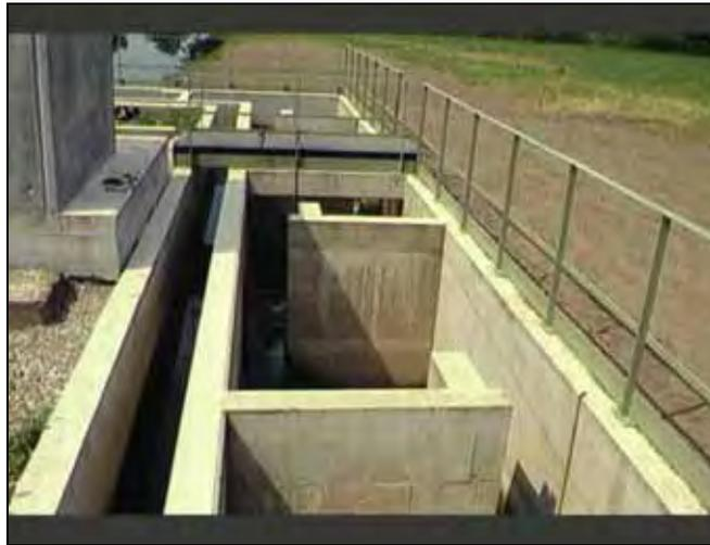
Exemple de dispositif de franchissement d'un obstacle transversal
