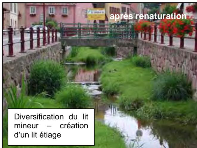
Exemple de la diversification du lit mineur d'un cours d'eau artificialisé
