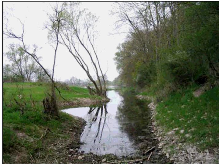
Exemple de réhabilitation d'une annexe hydraulique, mise en communication permanente par l'aval
