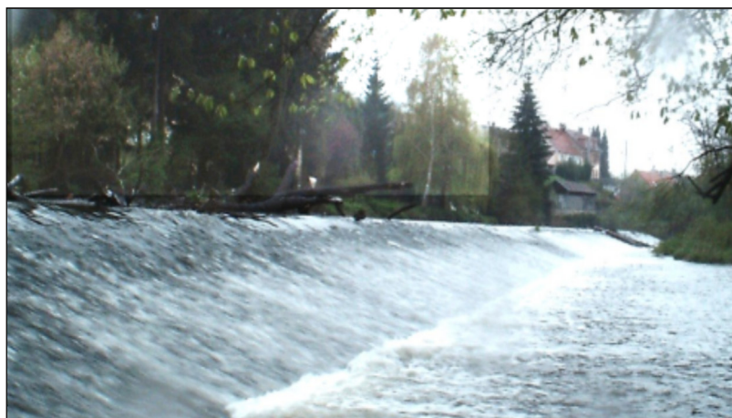
Exemple d'un obstacle transversal (photo : Agence de l'eau Rhin-Meuse)
