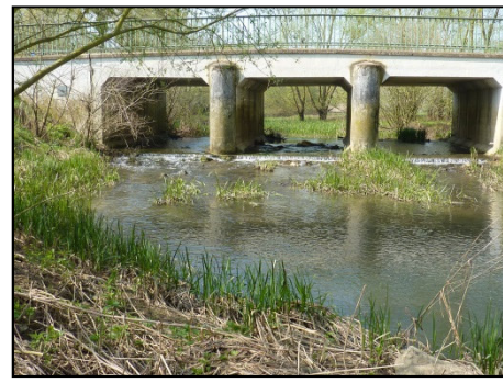
Formation d'un atterrissement au droit d'un pont (photo : Agence de l'eau Rhin-Meuse)
