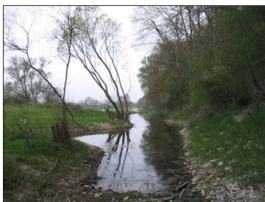
Exemple de réhabilitation d'une annexe hydraulique, avec réaménagement de la connexion par l'aval (photo : Agence de l'eau Rhin-Meuse)
