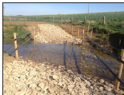
Aménagement d'un passage à gué et mise en place de clôture (photo : SW Environnement)
