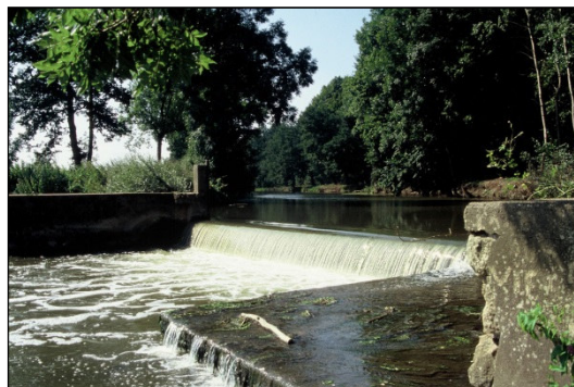
Exemple d'un ouvrage transversal sur un cours d'eau de taille plus modeste
