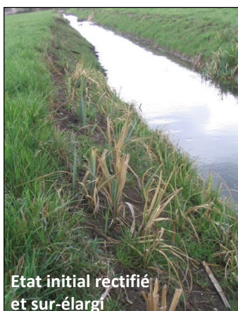
Exemple d'intervention visant à recréer de la sinuosité dans le lit (photos : Agence de l'eau Rhin-Meuse)
