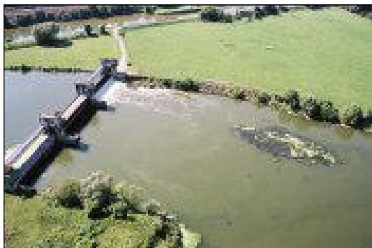
Exemple d'un ouvrage transversal sur un grand cours d'eau
