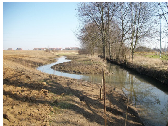
Exemple d'intervention de reméandrage par terrassement (photos : Agence de l'eau Rhin-Meuse)
