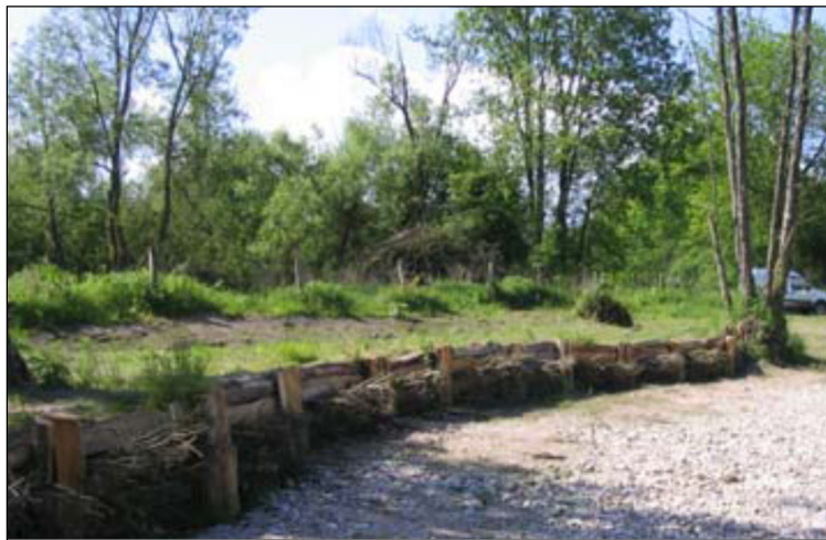
Exemple de protection de berges par des techniques de génie végétal (tunage en bois et lit de branches) (photo : Agence de l'eau Rhin-Meuse)
