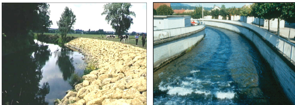
Exemple d'enrochement de berges et corsetage (photos : Agence de l'eau Rhin-Meuse)
