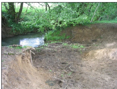
Piétinement des berges par le bétail (photo : Agence de l'eau Rhin-Meuse)
