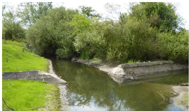
Effacement d'ouvrage sur le Mutterbach (photos : Agence de l'eau Rhin-Meuse)
