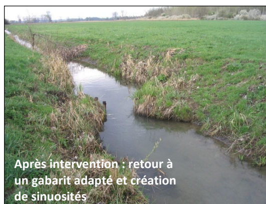
Exemple d'intervention visant à recréer de la sinuosité dans le lit (photos : Agence de l'eau Rhin-Meuse)
