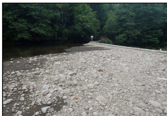
Exemple de seuil de prise d'eau avec écoulement uniquement dans le canal d'aménée (photo : OFB)
