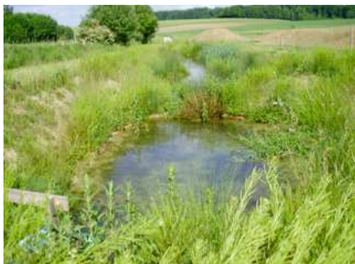
Figure 5 : Dispositif « fossé long en trois bassins »
